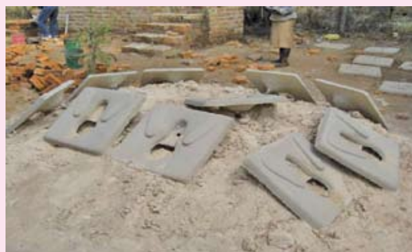
Inodoro EcoSan con placa turca de concreto con separación de orina hecho por los participantes
