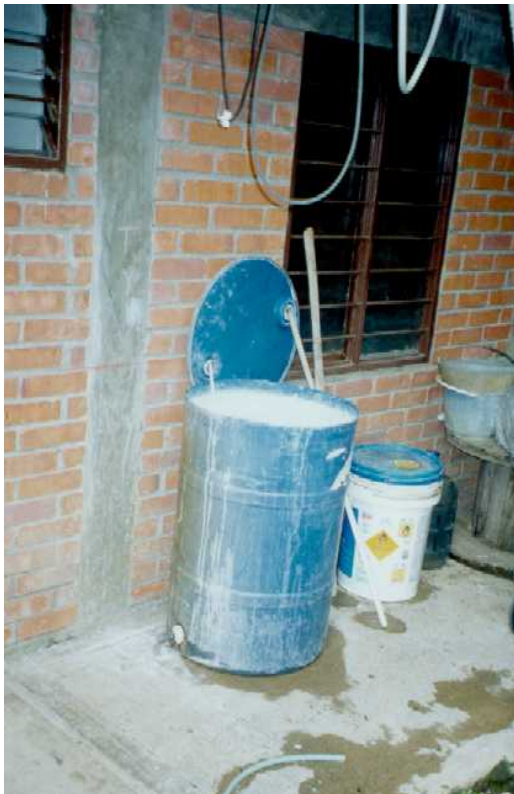
Foto 7: Tanque de cloro
